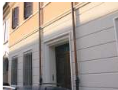
Rivestimento con termocappotto fugato e decorazione di facciate, finestre e portali con profili e modanature Hidra® Edge
