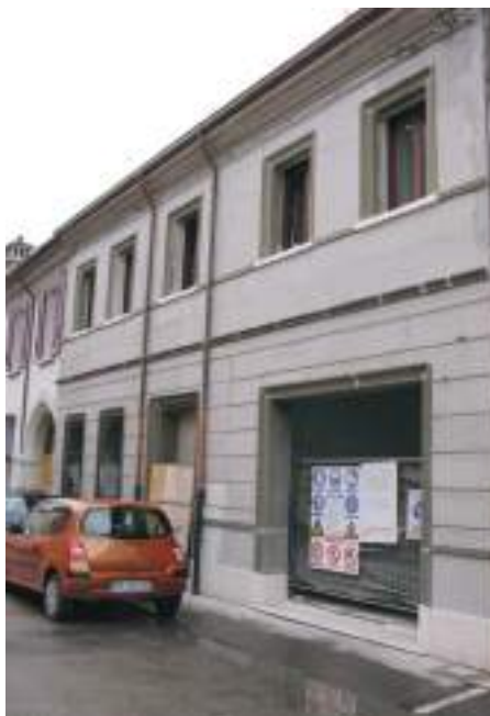
Rivestimento con termocappotto fugato e decorazione di facciate, finestre e portali con profili e modanature Hidra® Edge
