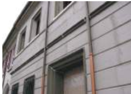
Rivestimento con termocappotto fugato e decorazione di facciate, finestre e portali con profili e modanature Hidra® Edge
