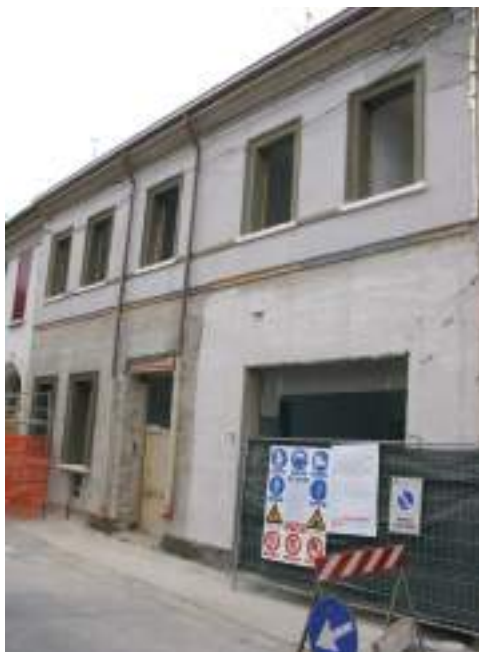
Rivestimento con termocappotto fugato e decorazione di facciate, finestre e portali con profili e modanature Hidra® Edge
