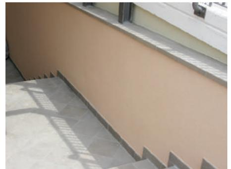
An Erdreich grenzende Stahlbetonwände einer unterirdischen Rampe mit Infiltrationen aus dem dahinter liegenden Erdreich. Behandlung durch Abtragen der Oberfläche und Anwendung eines Zyklus zur negativen Abdichtung.
