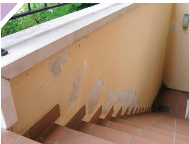
Negative Abdichtung von Strukturen gegen Erdreich, die dem Druck des dahinter liegenden Erdreichs ausgesetzt sind.
