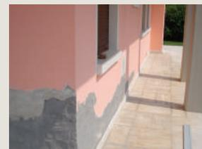
Eine erste Schicht Ausgleichputz Hegea® 2.0. auftragen. Faser-Putznetz einlegen\*.
