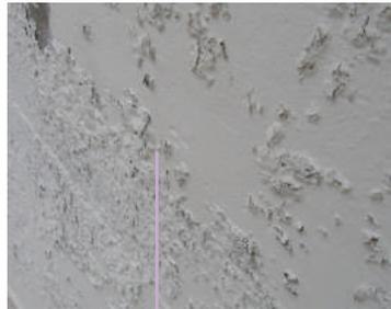
An den aus Erdreich bestehenden Wänden der Außentreppe von Reihenhäusern sind Flecken und in Ablösung befindliche bzw. nicht mehr zusammenhängende Bereiche zu erkennen. Behandlung durch Abtragen der Oberfläche und Anwendung eines Zyklus zur negativen Abdichtung.
