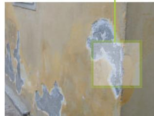
In einem gewerblichen Gebäude mit aufsteigender Nässe bis auf beachtliche Höhe wurden die oberflächlichen Schichten abgetragen und eine Hegea®-Behandlung gegen aufsteigende Kapillarnässe mit eingelegtem Putznetz aufgetragen.
