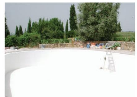
Die Innenwände eines Schwimmbads zeigen abgelöste und unzusammenhängende Bereiche. Behandlung durch Abtragen der Oberfläche und Anwendung eines Zyklus zur positiven Abdichtung.
