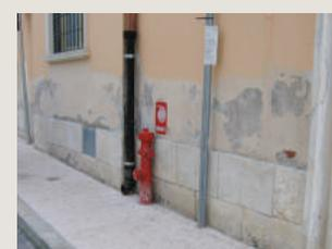
Das Anbringen von Sockelleisten aus Stein auf der Außenseite schränkt die Atmungsfähigkeit drastisch ein, so dass die angrenzenden freien Mauerbereiche überlastet werden. Das Beibehalten von Sockelleisten und Steinbelägen führt demzufolge zu einer Verlagerung der zu behandelnden Bereiche.
