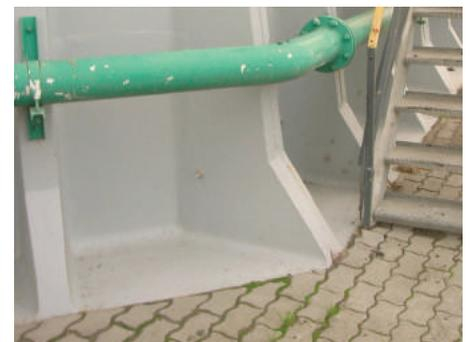
Wände einer Anlage zur Abwasser-Ableitung mit Infiltrationen und Tropfnässe aus den dahinter liegenden Tanks. Behandlung durch Abtragen der Oberfläche und Anwendung eines Zyklus zur negativen Abdichtung.
