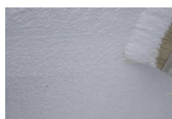
Es empfiehlt sich die Verwendung von Faserputznetz 150/160 m<sup>2</sup>. Bei Einlegen von Putznetz ist es nicht notwendig, die für den nächsten Auftrag angegebenen Zeiten einzuhalten.
