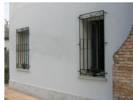
In dieser Wohnung mit bis auf beachtliche Höhe aufsteigender Nässe wurden die oberflächlichen Schichten abgetragen und eine Hegea®-Behandlung gegen aufsteigende Kapillarnässe mit eingelegetem Putznetz aufgetragen.
