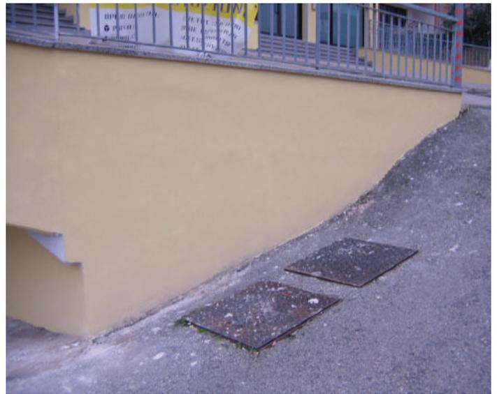
An Erdreich grenzende Wände einer unterirdischen Rampe mit Infiltrationen aus dem dahinter liegenden Erdreich. Behandlung durch Abtragen der Oberfläche und Anwendung eines Zyklus zur negativen Abdichtung.
