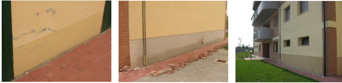
Intonaci di recente posa ma con mediocre coesione, presentavano umidità di risalita per capillarità. Al fine di garantire l'adeguata consistenza delle malte, previa rimozione delle sole sezioni corticali mediante fresatura delle superfici, si è resa necessaria la posa del consolidante di profondità Hegea Silikat. A maturazione completa, trattamento con ciclo Hegea.
