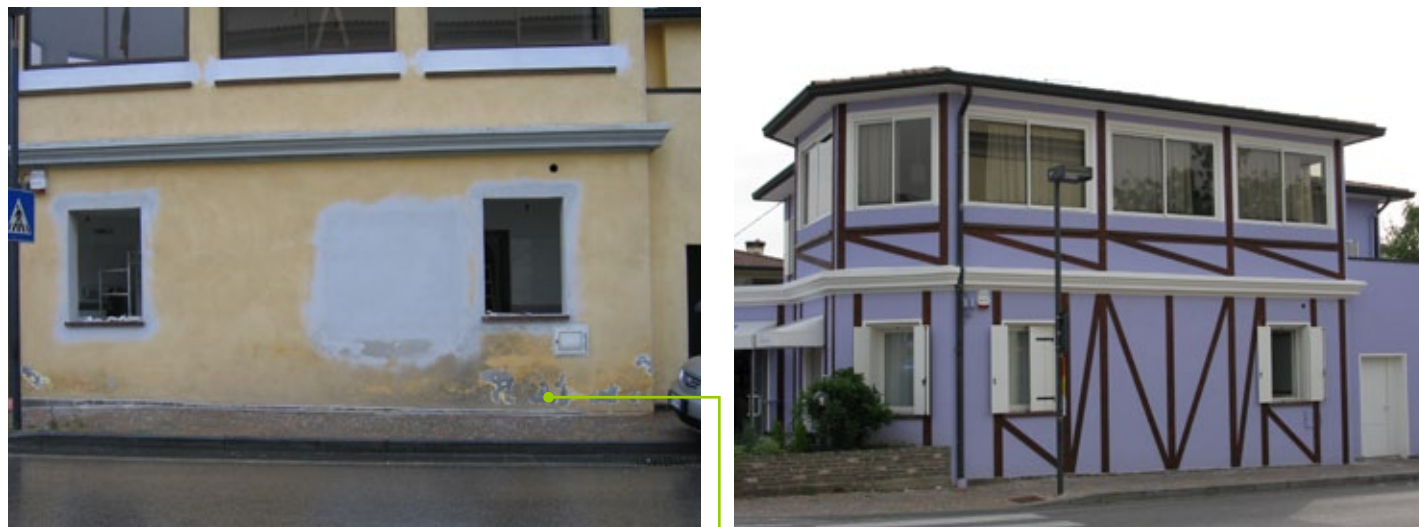
In attività commerciale con problematiche di umidità di risalita ad altezze elevate, abrasione superficiale, trattamento ciclo umidità di risalita capillare ed interposizione di rete.
