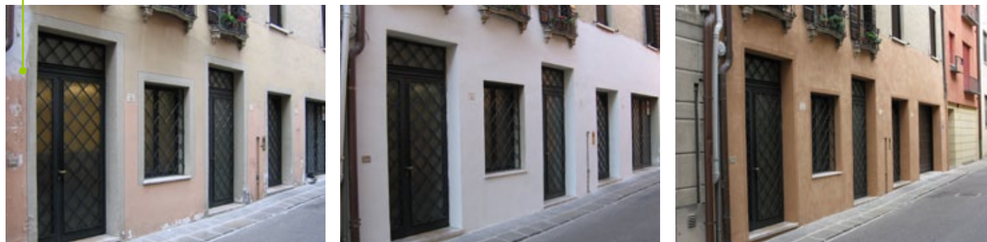
In edificio di centro storico con intense problematiche di umidità di risalita, abrasione superficiale, trattamento ciclo umidità di risalita capillare ed interposizione di rete.
