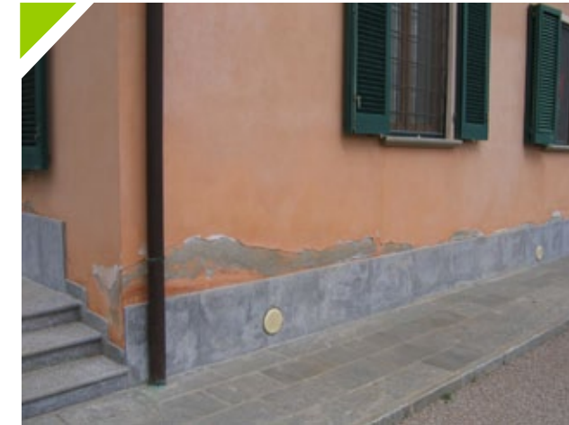
Umidità di risalita capillare: sviluppo di efflorescenze con distacchi di tinteggiature e rasanti.
