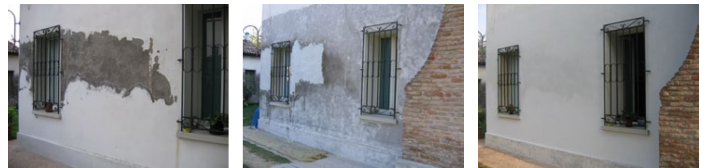
In abitazione con problematiche di umidità di risalita ad altezze elevate, abrasione superficiale, trattamento ciclo umidità di risalita capillare ed interposizione di rete.
