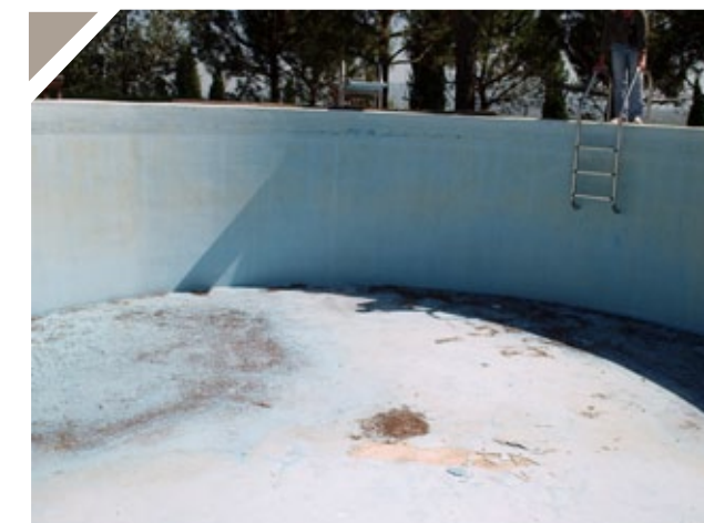
Impermeabilizzazioni positive: infiltrazioni localizzate o diffuse in strutture atte al contenimento di liquidi o terreno.
