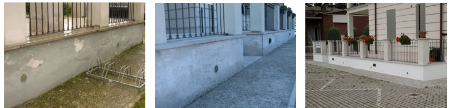
In condominio con problematiche di umidità di risalita e colature su mura perimetrali, abrasione superficiale e trattamento con prodotti hegea ed interposizione di rete
