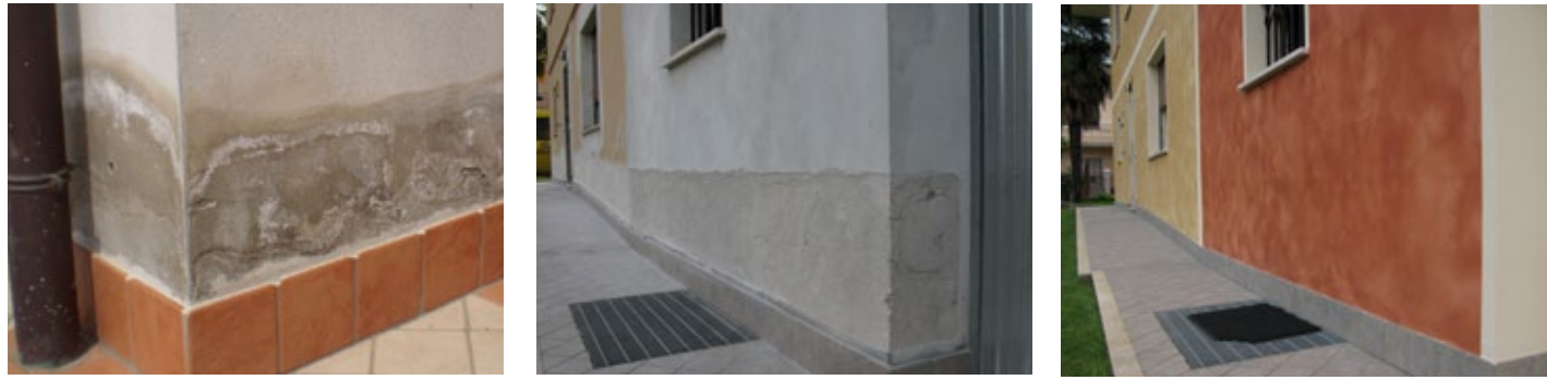
La presenza di umidità di risalita su intonaci in buono stato di coesione, ha determinato un facile intervento con rimozione delle sole sezioni corticali mediante fresatura delle superfici e successivo trattamento con ciclo Hegea.
