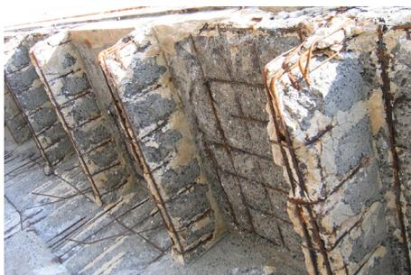
Passivante antiruggine per ferri di armatura e promotore di adesione per malta da ripristino. Prodotto in polvere a base di cementi modificati, inerti selezionati, leganti polimerici alcaliresistenti ed additivi specifici. Specifico per consentire una perfetta passivazione sui ferri d'armatura e una buona adesione delle malte sul calcestruzzo da ripristinare.
