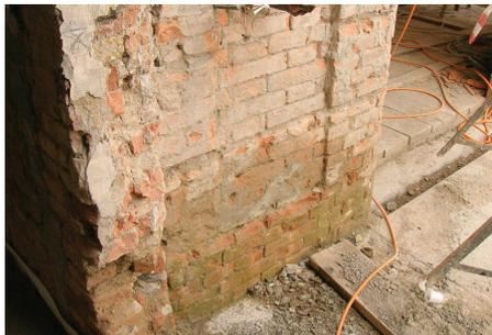
Malta deumidificante a spessore per ripristini verticali e risanamento di murature umide. Intonaco per esterno - interno a spessore minimo 2cm, dotato di ottima lavorabilità. Composto premiscelato a base di cementi, additivi specifici e sabbie industriali a granulometria max 1,2 mm. Ciclo comprendente Hydra san Primer, Hydra San e Hydra Mineral.
