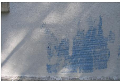
Rete per cicli di termocappotto e rasature armate, con bande guida laterali per sormonti. 150gr/m<sup>2</sup>, rotolo 50m. Impiegabile per cicli armati di termocappotto con Hidra® Coll nell'isolamento termico. Fondamentale per rasature armate con ciclo Hegea® per recuperare sezioni cavillate, crepe, angoli, innesti e fondi incoerenti.
