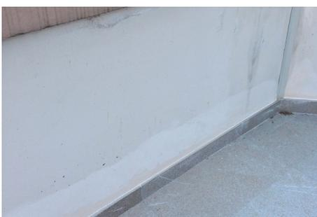
Rasante per finiture di colore Bianco, per esterno - interno a base di cemento bianco 52.5 e additivi specifici (0.1 mm), con proprietà di deumidificazione o impermeabilizzazione nell'ambito di specifici cicli applicativi. Impiego esclusivo per finiture di cicli di deumidificazione ed impermeabilizzazione Hegea.
