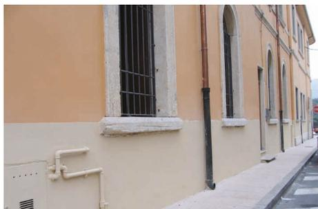
Rasante fibrato per sottofondo di colore grigio, per esterno - interno a base di cemento grigio 52.5, additivi specifici, fibre e sabbia silicea c.a. Ø 2 -1,5mm, con proprietà di deumidificazione o impermeabilizzazione nell'ambito di specifici cicli applicativi. Costituisce la base di tutti i cicli di deumidificazione ed impermeabilizzazione Hegea.
