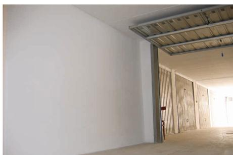
**Rasante cementizio bianco per interno/esterno a finitura estremamente liscia (granulometria 0,1mm).** Idoneo per rasare calcestruzzo ed intonaci cementizi stagionati ed il riempimento di microfessurazioni e cavillature del supporto. Composto cementizio a base di inerti selezionati, leganti idraulici, copolimeri vinilici ed additivi specifici, dotato di ottima spatolabilità.
