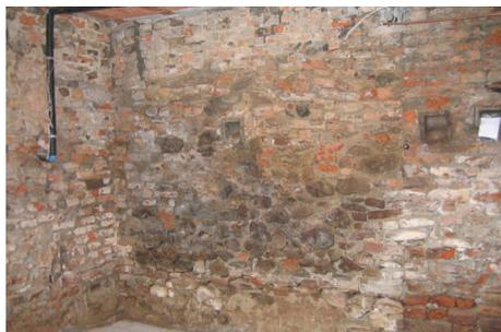
Impregnante costituito da una miscela di silicati e prodotti silicatici. Idoneo per il bloccaggio di efflorescenze e sbarramento a fenomeni di umidità di risalita capillare, nell'ambito di ciclo deumidificante standard a spessore con impiego di Hidra® San.
