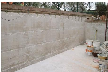
Malta tixotropica antiritiro fibrinforzata per il ripristino verticale del calcestruzzo, cemento armato ed intonaci a base cemento. Composto premiscelato a base di cementi, additivi specifici, fibre e sabbie industriali a granulometria max 1,2 mm. Applicabile ad elevati spessori fino a 4 cm praticamente privo di ritiro (spessore minimo 1 cm).
