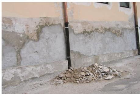
Malta da rinzaffo e ripristini minerale a base di cemento calce ed inerti selezionati. Composto premiscelato costituito da leganti idraulici, inerti, additivi specifici e fibre, idoneo per il rinzaffo di murature vecchie e degradate in laterizi, mattoni pieni, pietra naturale, applicabile in spessore unico fino a 2-3cm (spessore minimo 0,8cm).
