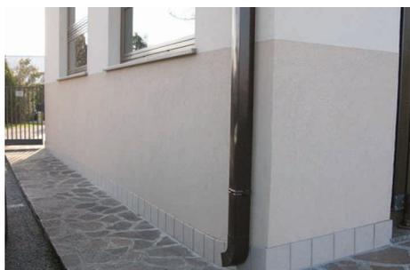
Rasante per finiture di colore grigio, per esterno - interno a base di cemento grigio 52.5, additivi specifici e sabbia silicea c.a. Ø 0,2 -0,6mm, con proprietà di deumidificazione o impermeabilizzazione nell'ambito di specifici cicli applicativi. Impiego esclusivo per finiture di cicli di deumidificazione ed impermeabilizzazione Hegea.
