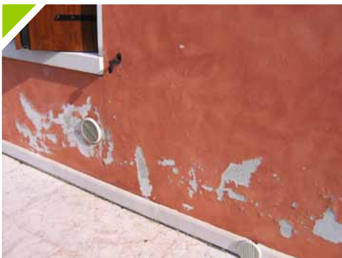
Umidità di risalita capillare: sviluppo di efflorescenze con distacchi di integgiature e rasanti.
